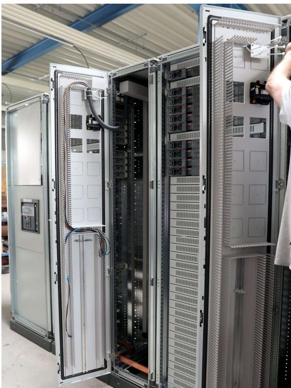
Das Highlight des Projekts ist die pro E Power Niederspannungshauptverteilung. Sie besteht aus zwei Schrankreihen von je 8 Metern.
